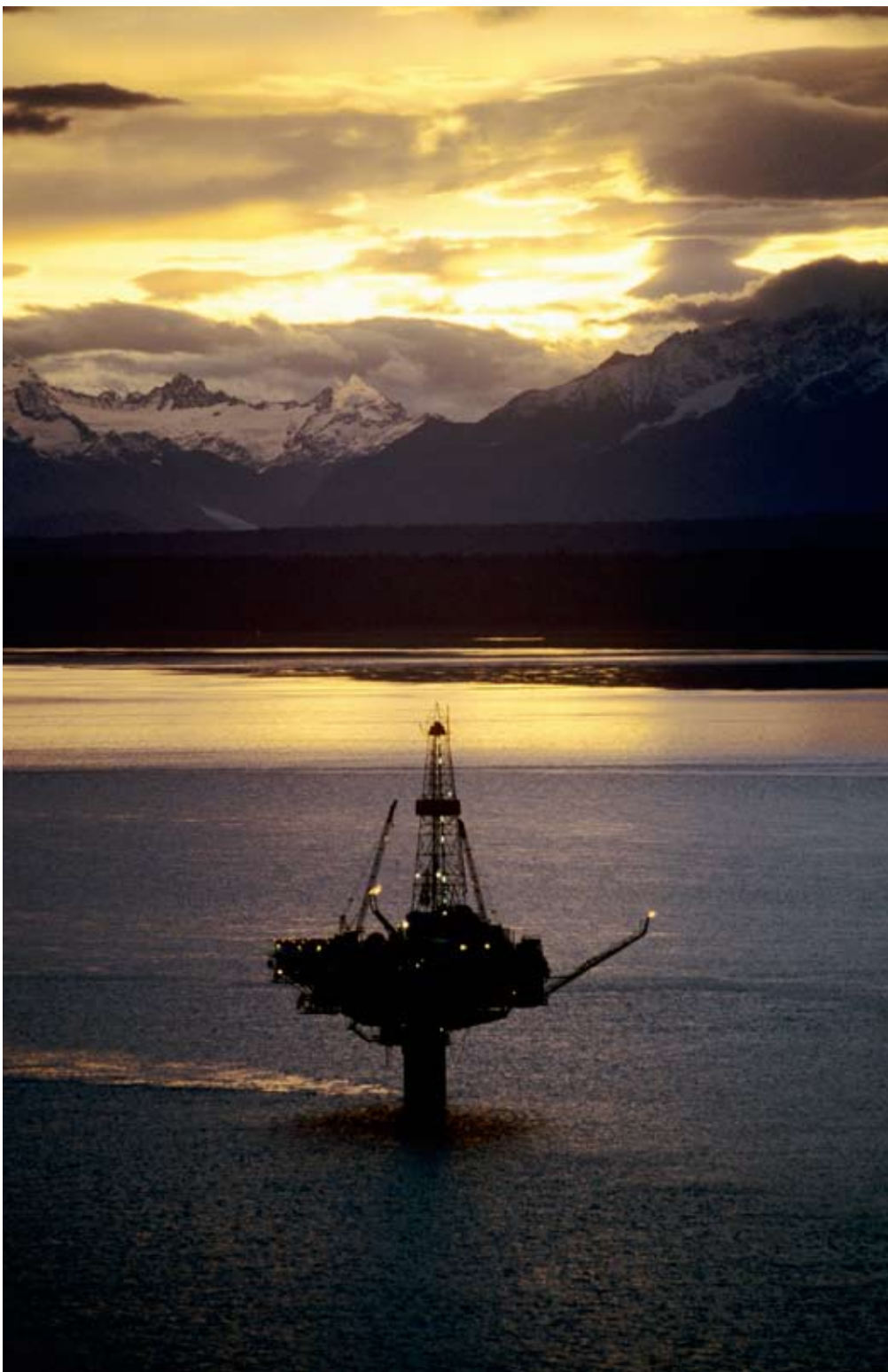
Plate-forme pétrolière en mer, Alaska, USA
