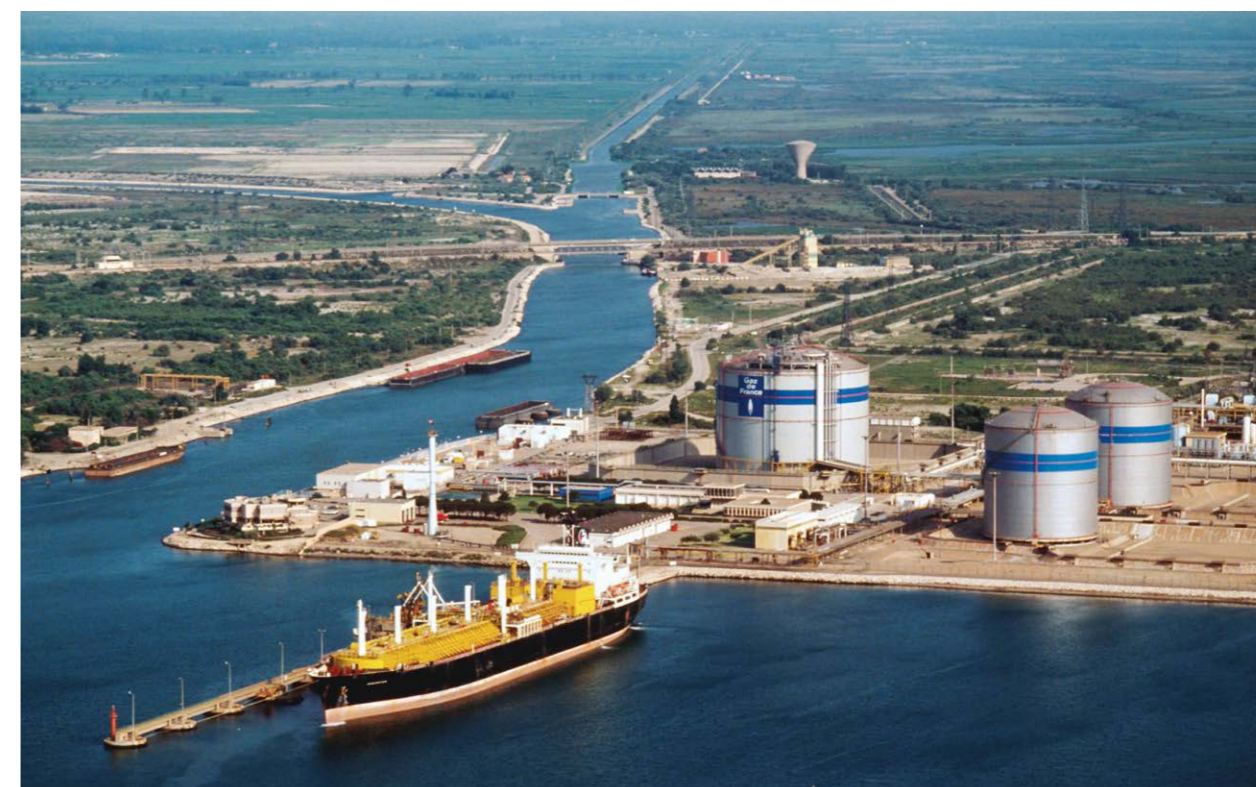
Port industriel de Fos-sur-Mer, France
